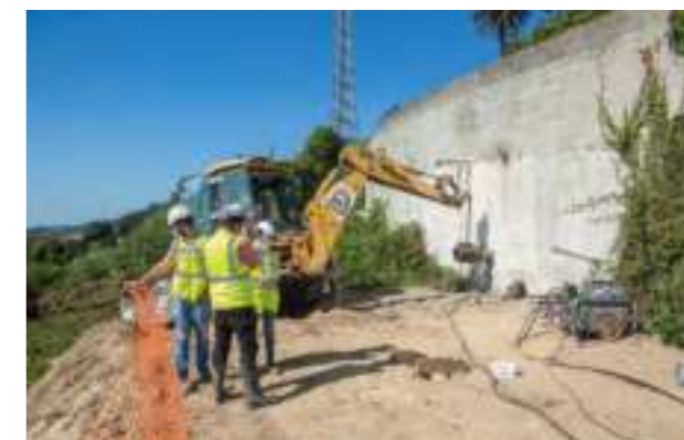
Los trabajos en A Graña.
